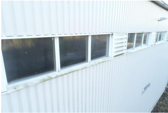
Kuva 32. Korkean osan ikkunat vaikuttivat dronetarkastelussa kunnossa olevilta.
