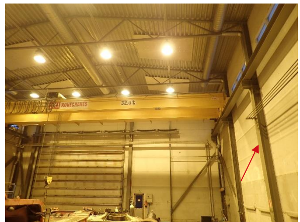
Kuva 20. Yleiskuvaa uudesta hallista, kantavat rakenteet teräspilareita
