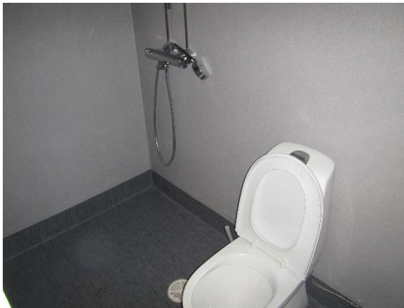
Kuva 75. Uusittua vesikalustusta toimistotiloissa.
