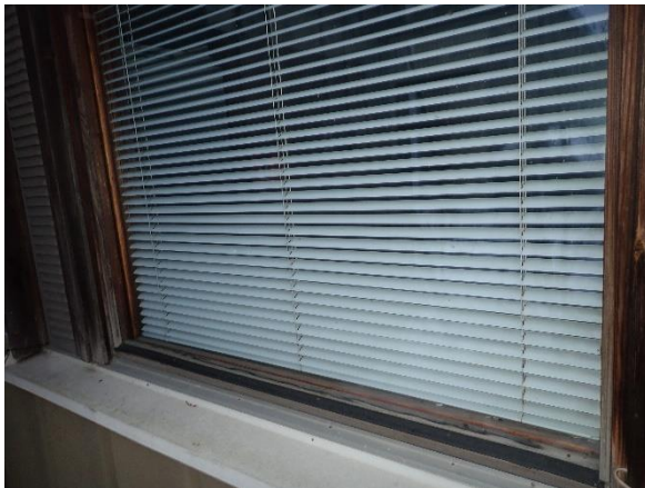
Kuva 28. Yleiskuvaa toimiston ikkunasta ulkopuolelta
