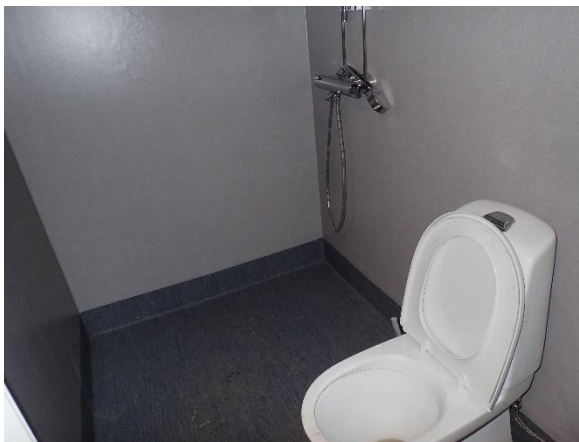
Kuva 47. Yleiskuva suihku / wc-tilasta.
