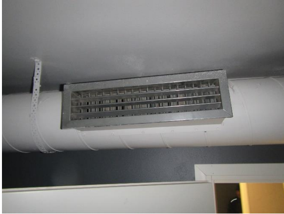
Kuva 86. Mahdollinen tuloilmasäleikkö toimistotiloissa. Kuva 87. Tuloilmahajottaja hallitiloissa.
