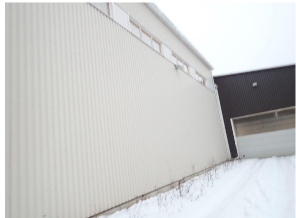
Kuva 22. Uudemman hallin julkisivu pellitystä
