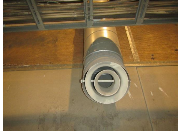
Kuva 86. Mahdollinen tuloilmasäleikkö toimistotiloissa. Kuva 87. Tuloilmahajottaja hallitiloissa.
