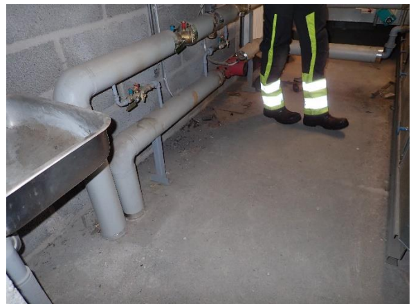
Kuva 54. Vanhemman hallin harkko-väliseinää.
