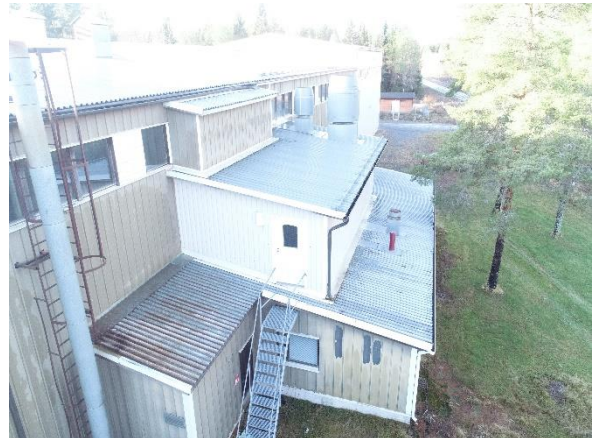
Kuva 42. Yleiskuvaa toimistorakennuksen kohdalta.
