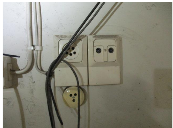
Kuva 117. Antenni- ja telerasioita.
