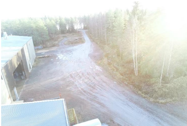
Kuva 2. Yleiskuvaa rakennuksen etupihasta
