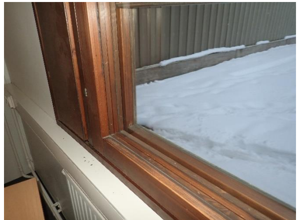
Kuva 29. Yleiskuvaa toimiston ikkunasta sisäpuolelta
