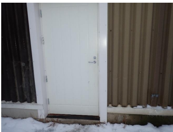
Kuva 33. Vanhemman hallin uusittu ovi
