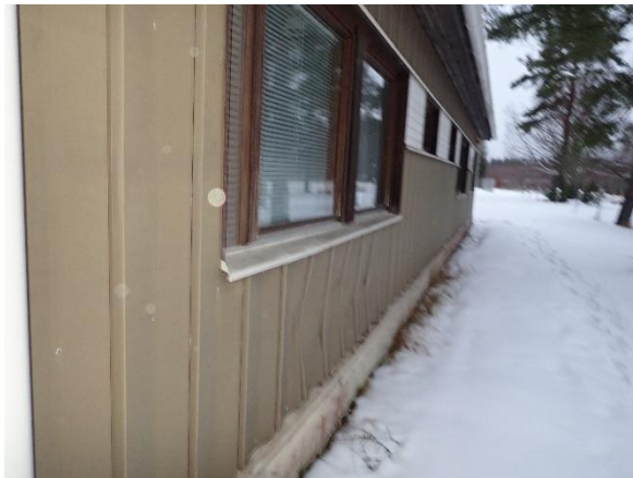
Kuva 11. Yleiskuvaa toimistorakennuksen perustuksista
