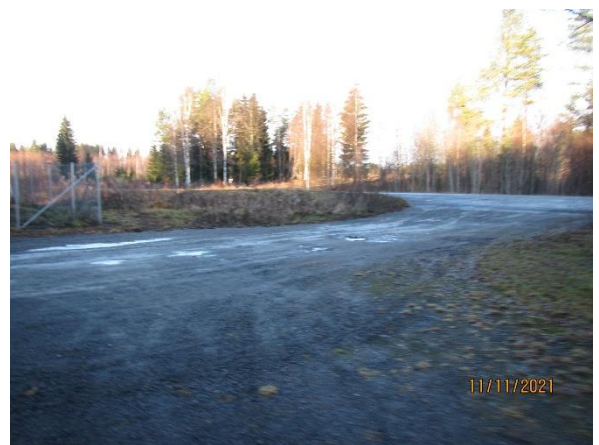
Kuva 5. Pihatiellä on monttuja joihin vesi lätäköityy
