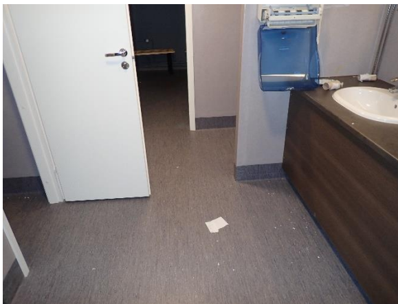
Kuva 16. Toimistojen ja sos. tilojen lattiapinnoitteen on muovimattoja
