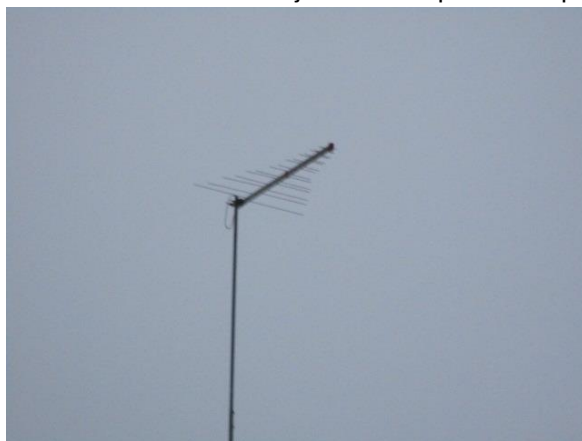
Kuva 116. Harava-antenni katolla.
