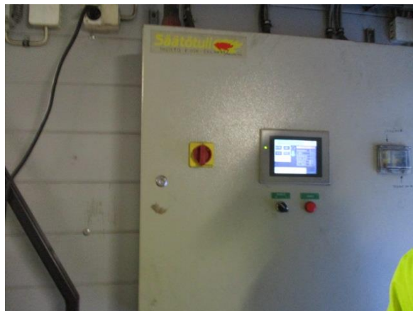
Kuva 124. Kattilahuoneen automaatiokeskus
