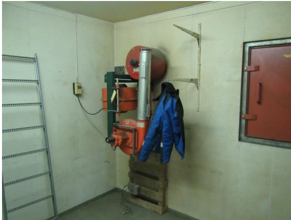
Kuva 90. Väestönsuojan ilmanvaihtolaitteisto.
