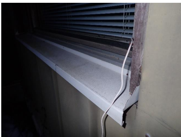
Kuva 30. Ikkunapellitysten kallistus loiva
