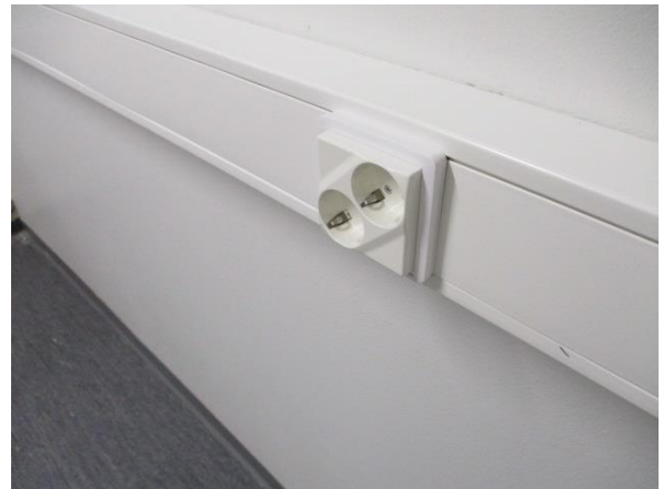
Kuva 92. Kaapelikouru näkymää, uusia asennuksia.
