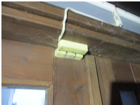
Kuva 119. Ovikoskettimia, murtolaitteisto.
