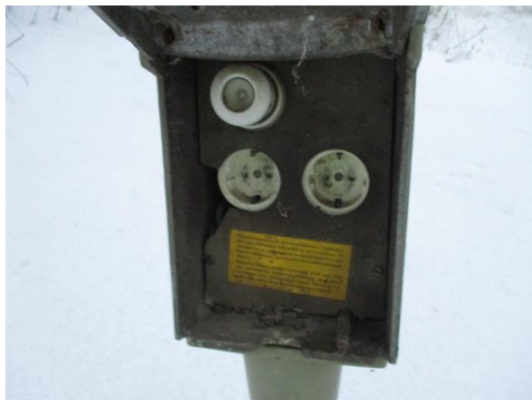
Kuva 106. Autolämmityskoteloita, avoinna.
