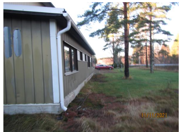
Kuva 8. Pintamaat eivät juuri vietä rakennuksista pois päin.
