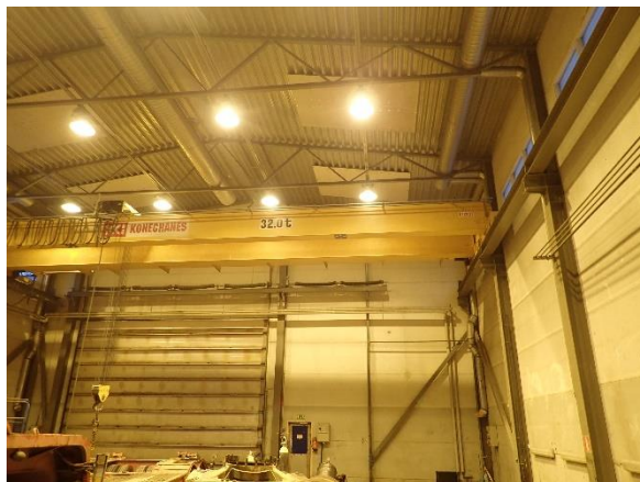
Kuva 56. Uudemman hallin peltiseinää.
