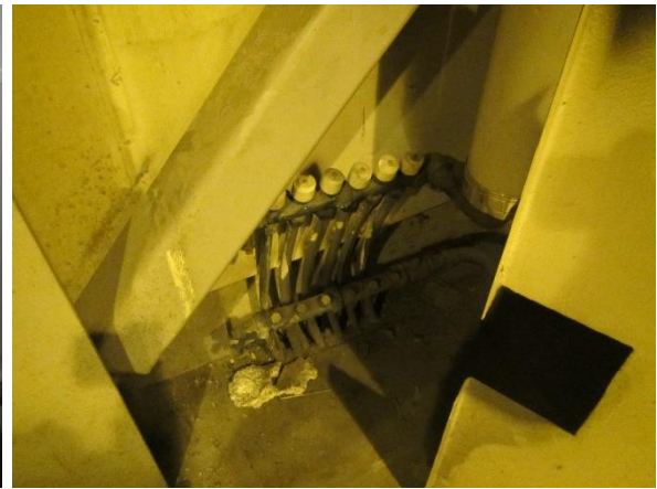
Kuva 72. Lattialämmityksen jakotukki.
