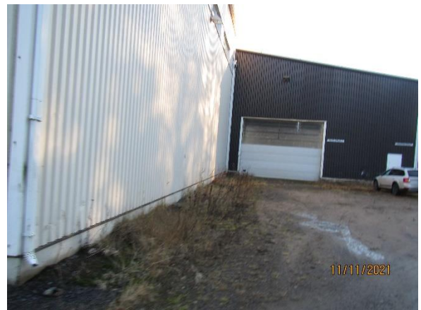
Kuva 10. Yleiskuvaa uudemman hallin perustuksista
