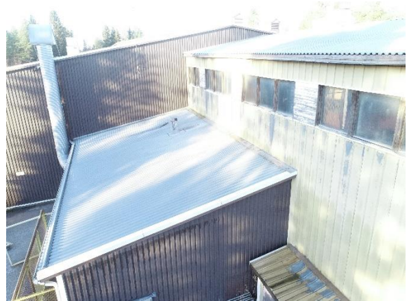
Kuva 40. Yleiskuvaa etupihan puolelta vanhan hallin kohdalta.
