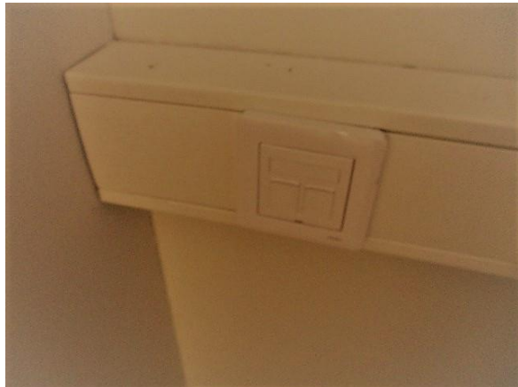
Kuva 118. ATK-rasioita toimistotiloissa.
