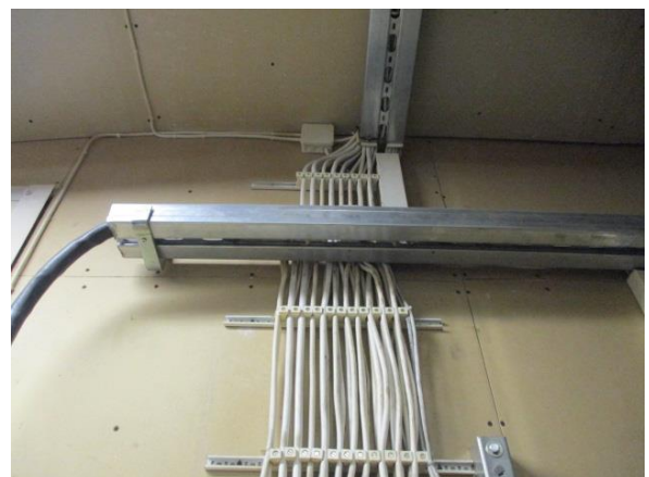
Kuva 94. Johtoasennuksia teknisessä tilassa.
