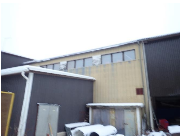
Kuva 25. Keltaisen hallin peltiverhouksen pinnoite irronnut, myös puuosissa on kunnostustarvetta.
