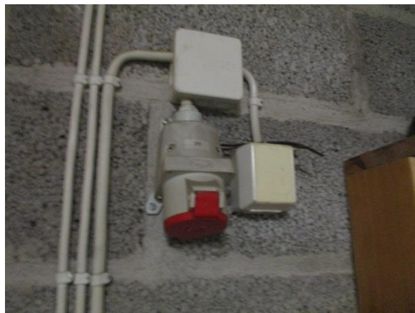
Kuva 103. Pintakalusteita.
