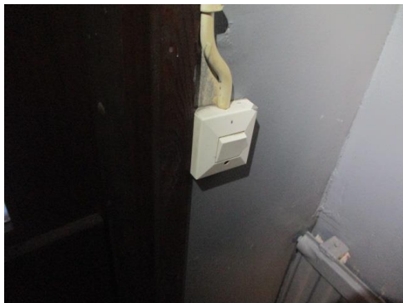
Kuva 104. Pintakytinkelusteita, vanhempia.
