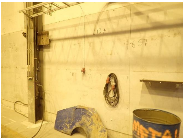
Kuva 55. Uuden hallin levyseinä pintaa.
