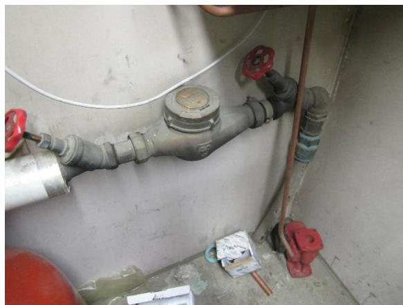
Kuva 74. Päävesimittari.
