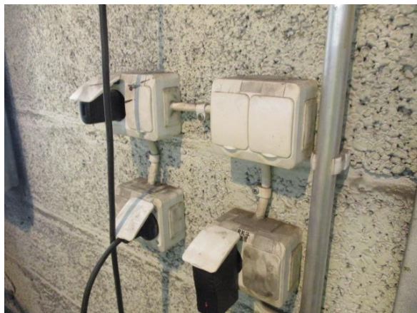
Kuva 102. Pintakalusteita.
