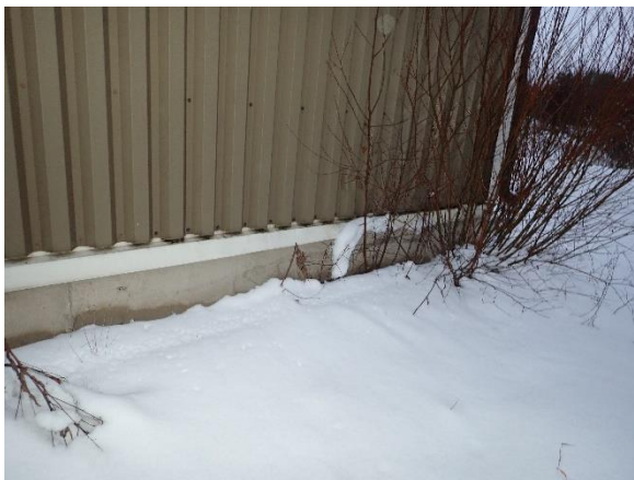
Kuva 9. Yleiskuvaa vanhan hallin perustuksista
