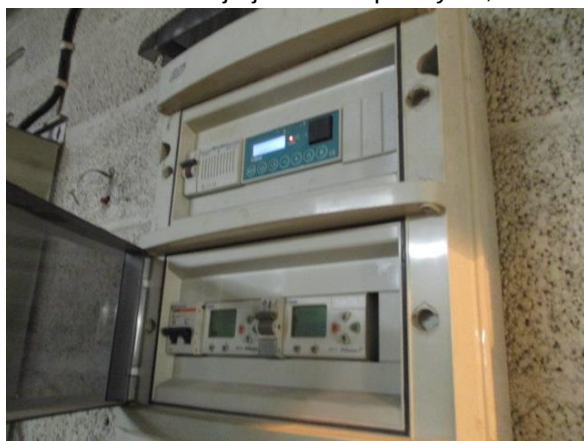
Kuva 121. Automaatiolaitteisto, keskusyksikkö.
