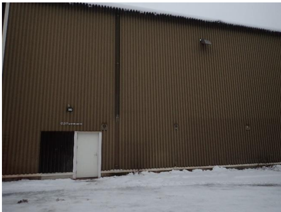
Kuva 21. Yleiskuvaa vanhemman hallin ulkoseinää
