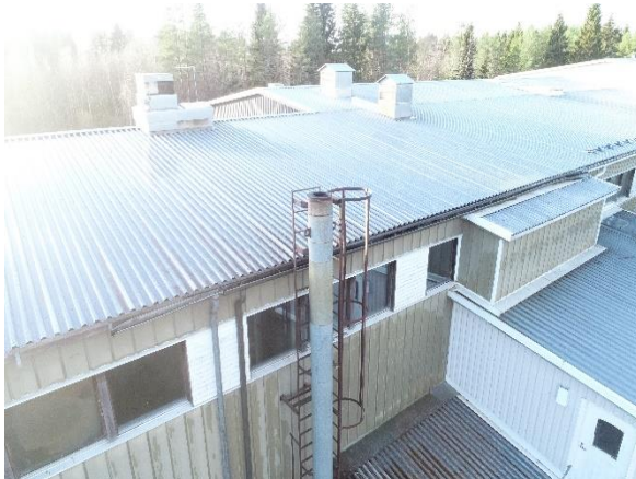
Kuva 41. Yleiskuvaa pannuhuoneen kohdalta.
