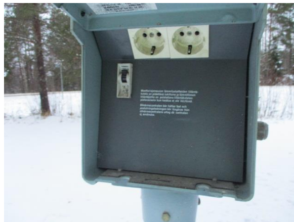
Kuva 107. Uusittuja autolämmityskoteloita.
