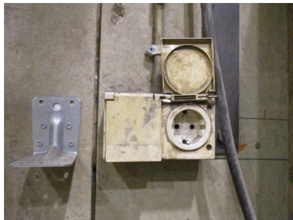
Kuva 105. Alkuperäisiä pistorasiakalusteita.
