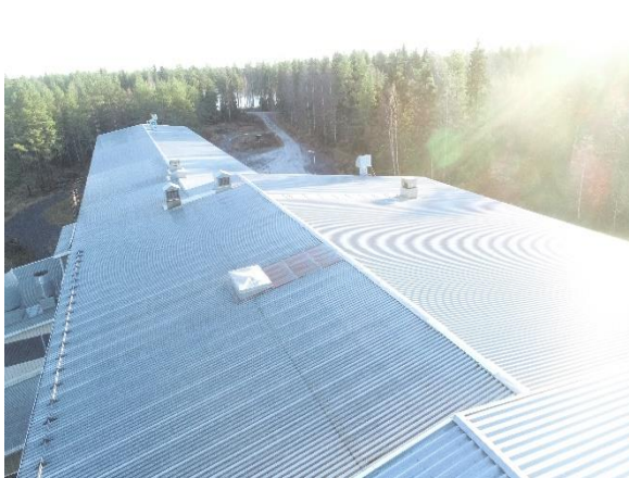
Kuva 37. Yleiskuvaa hallien katoilta
